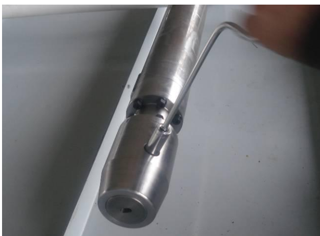
Фото 3: Демонтаж клапана обратного
