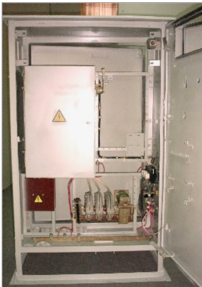
Рисунок 2.1 – Шкаф станции управления после демонтажа
