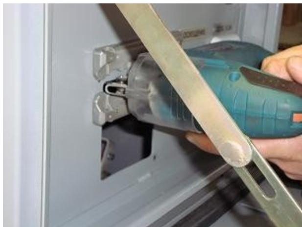
Фото 4. Вырезать отверстие под установку СКАД-2002(В)-УП.
