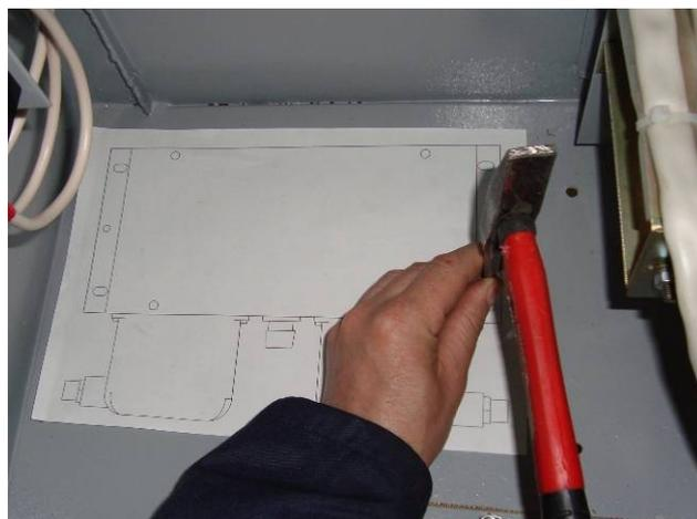
Фото 6 Разметить установочные отверстия под СКАД-2002(В)-БП
