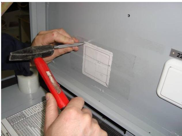
Фото 3. Разметить установочные отверстия под СКАД-2002(В)-УП
