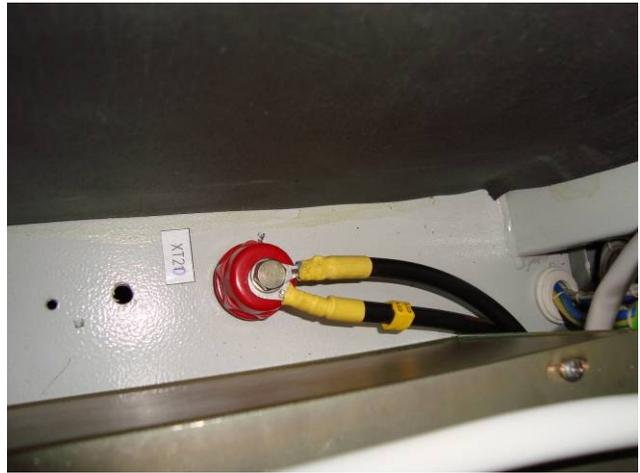
Фото 12. Присоединить выводы конденсаторов к изолятору XT20
