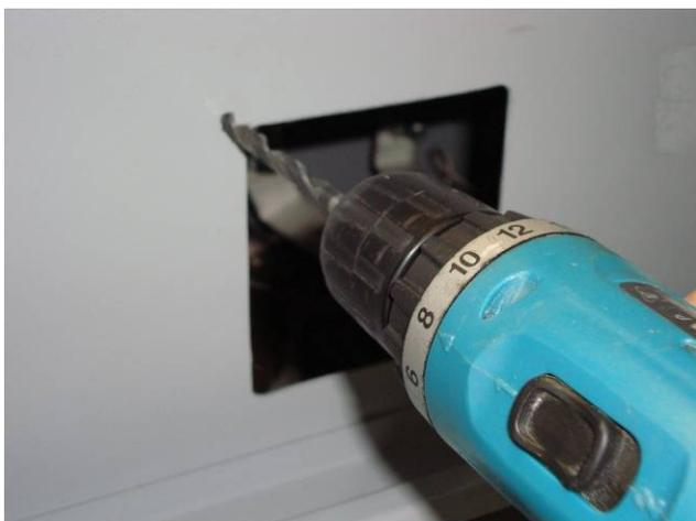
Фото 5. Просверлить крепежные отверстия
