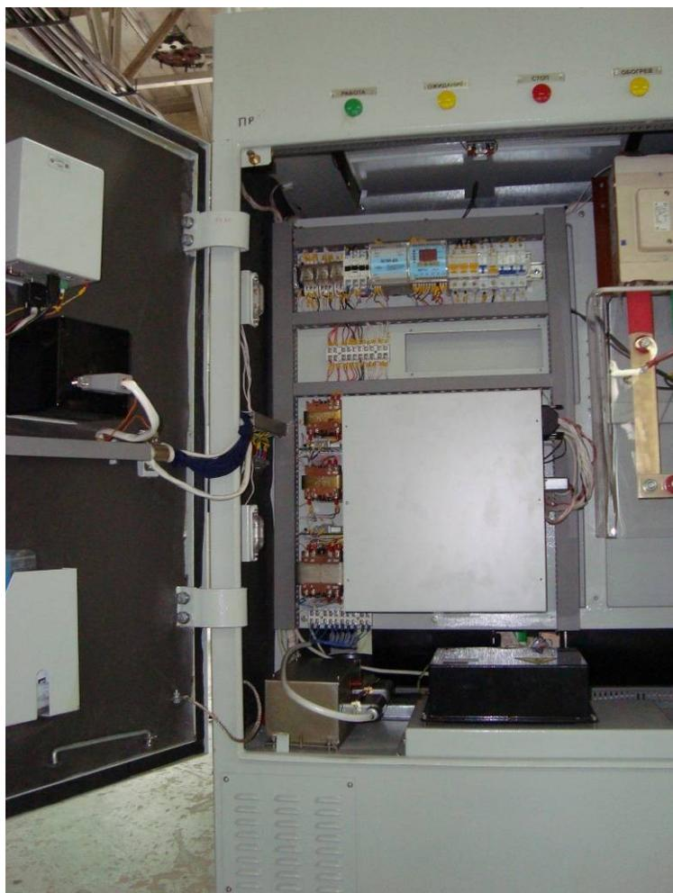
Фото 16. Станция ИРЗ-500 с установленной ТМС СКАД
