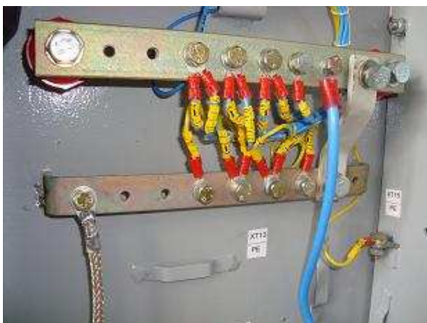
Рисунок 8. Подключение ТМС-Э5 к шине заземления СУ
