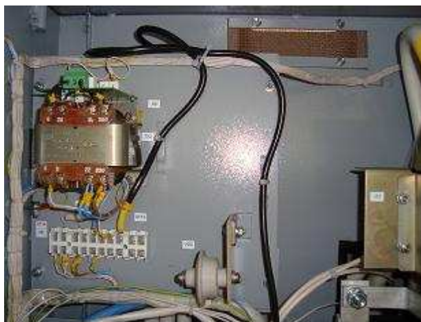
Рисунок 10. Расположение и крепление высоковольтного провода
