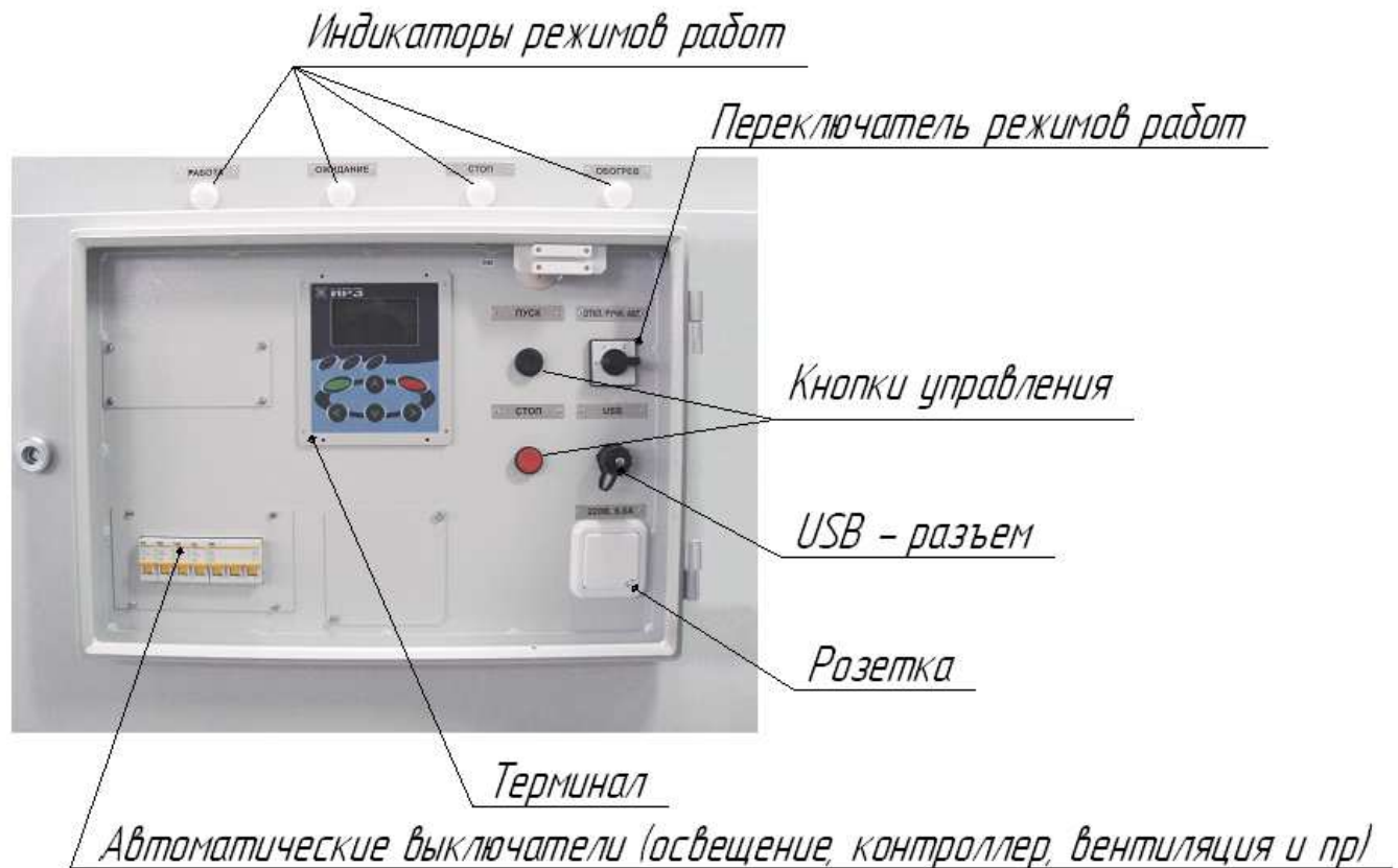
Рисунок 1.1 – Панель оператора станции управления ИР3-550 с открытой дверью
