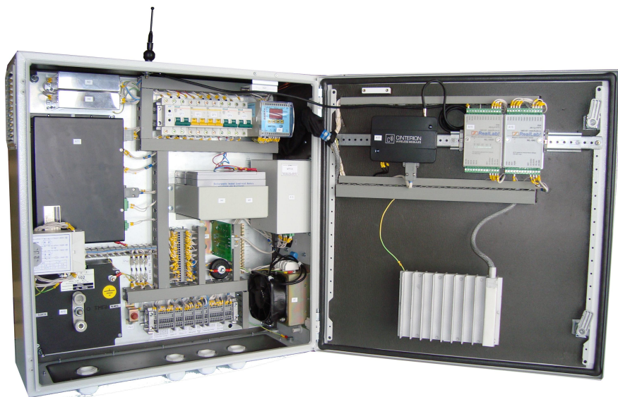
Рисунок Б.2 – Внутреннее устройство АСПТ-ДМ
