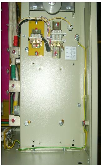
Рисунок 2. Монтажная панель для установки ТМС-Э5
